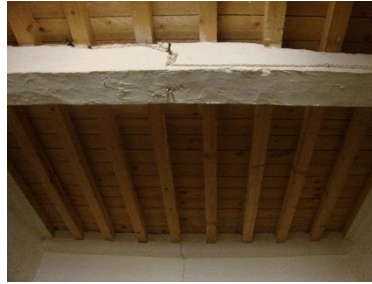
الشكل (11) يوضح كيفية وضع السقف على هيكل مصنوع من خشب الصنوبر
